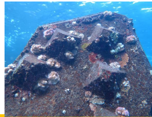
ACCROPODE™ II après 3 années de mise à l'eau
