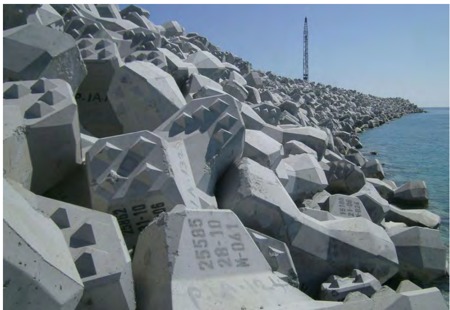
Figure 42 : projet aux Emirats Arabes Unis – « Upper Zakum »
