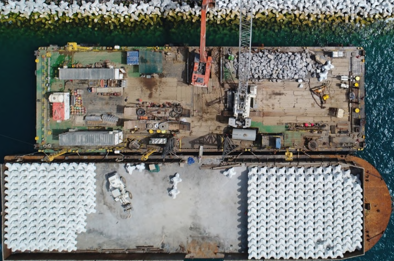
Figure 10 : photographie de mise en place de blocs ACCROPODE™ à la grue sur barge
