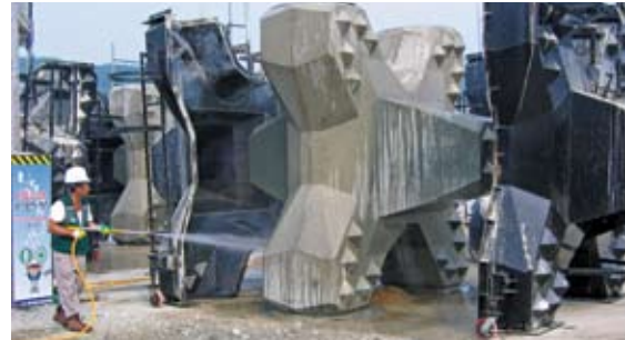
Opération de démoulage
