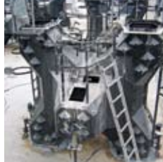
Moule prêt pour le bétonnage
